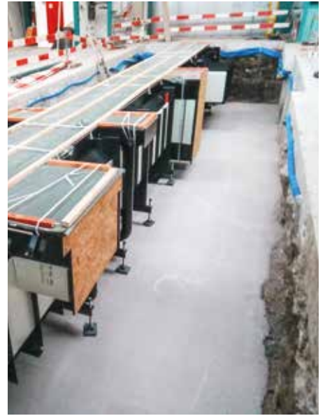
Die Fertigrube wird mit dem Hallenkran auf dem vorbereiteten Fundament abgesetzt.
