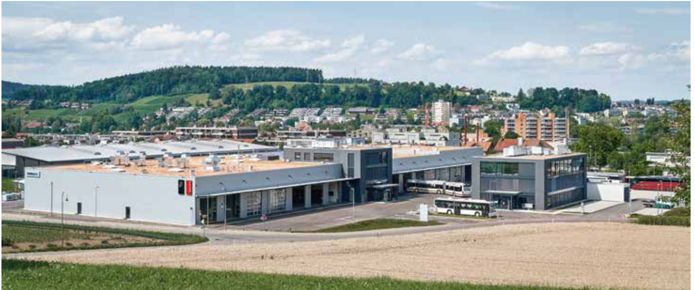
Grosszügiger Neubau von EvoBus (Schweiz) AG in Winterthur Wülflingen
