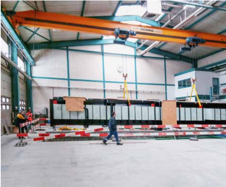
Die Fertigrube wird mit dem Hallenkran auf dem vorbereiteten Fundament abgesetzt.
