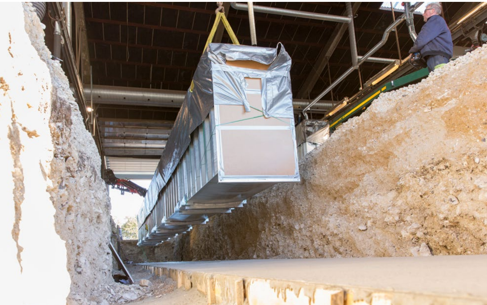
Bei der Installation einer Kassette muss der Betonsockel 150 mm dick und 1500 mm breit sein
