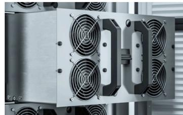
Diese Module sind das Herz der Ladestation. Je Powermodul können bis zu 4 Satelliten (S-Serie) mit je zwei Ladesteckern angeschlossen werden.
